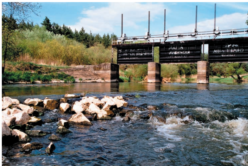
Fot. 5. Jaz na rzece Baryczy, podnoszony w okresie migracji ryb. W takiej sytuacji przy zsynchronizowaniu terminów migracji ryb z terminami otwierania jazu, budowa przepławki nie jest konieczna (fot. M. Kleszcz).
