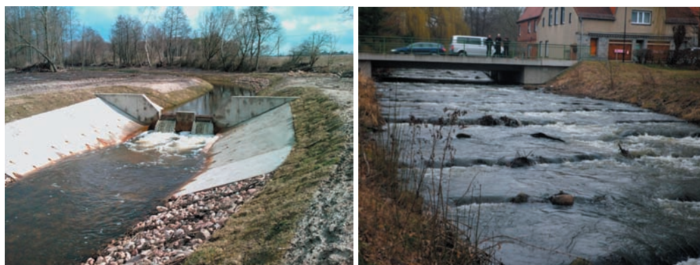
Fot. 3. Zabudowa progowa, stanowiąca duże utrudnienie (z lewej) oraz przyjazna (z prawej) dla migracji ryb (fot. A. Gieraj, W. Wiśniewolski).
