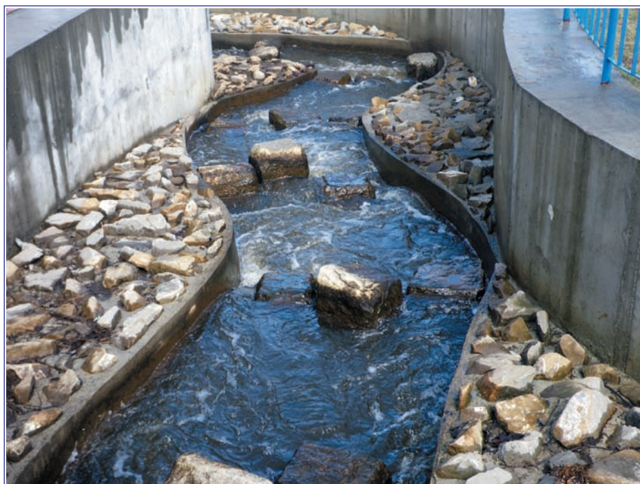
Fot. 4. Przepławka typu ryglowego. Pomędzy głazami rygła widoczne szczeliny migracyjne (fot. W. Wiśniewolski).
