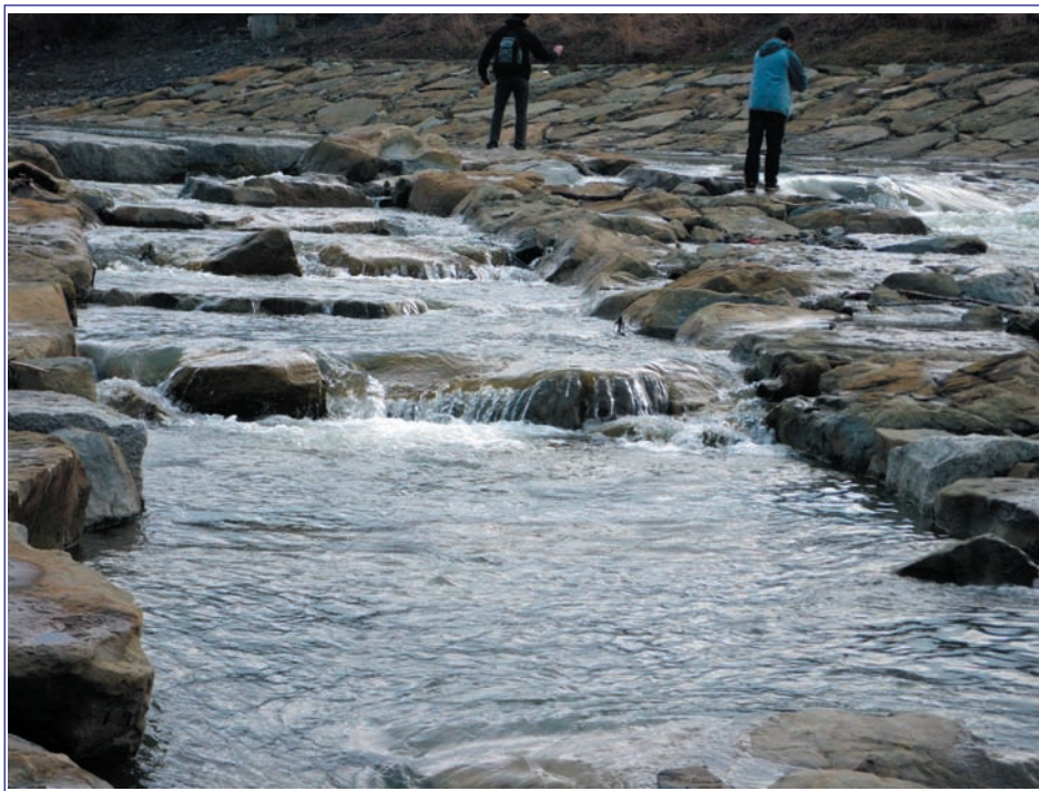
Fot. 2. Próg przebudowany w bystrotok kaskadowy posadowiony na całej szerokości koryta rzeki (fot. W. Wiśniewski).
