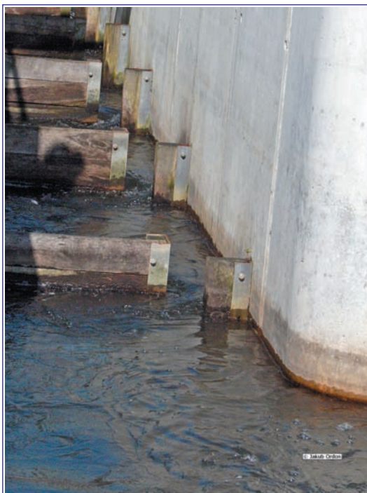
Fot. 5. Przeławka szczelinowa jednostronna (fot. J. Ordon).
