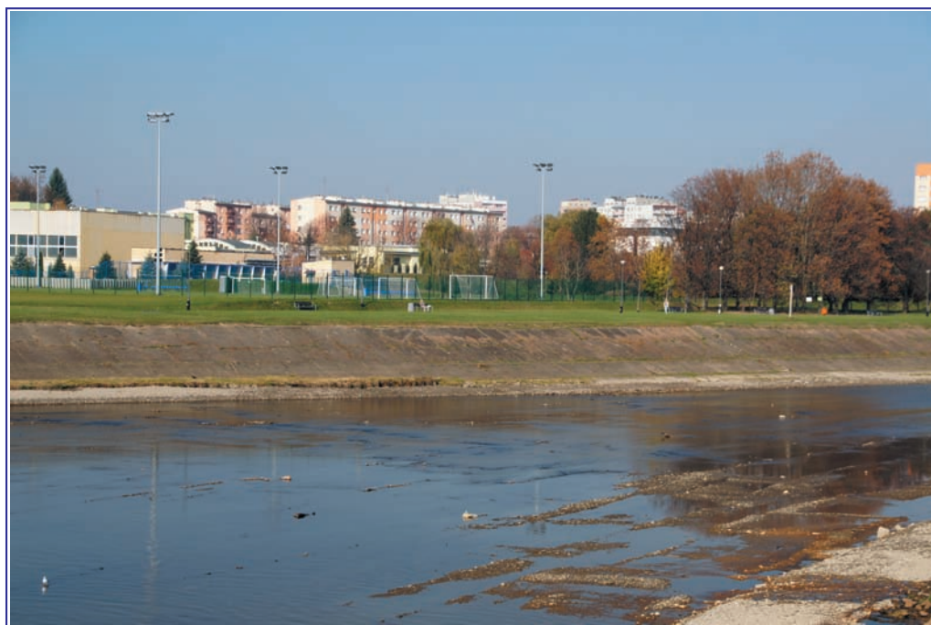
Fot. 2. Odcinek Wisłoka poniżej jazu w Rzeszowie po usunięciu wyspy w ramach prac utrzymaniowych (23. 10. 2013 r.) (fot. M. Adamczyk).
