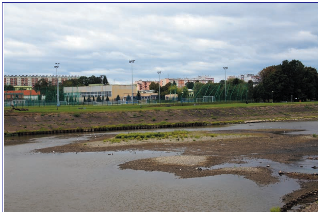
Fot. 1. Odcinek Wiśloka poniżej jazu w Rzeszowie przed wykonaniem prac utrzymaniowych (03. 09. 2013 r.) (fot. M. Adamczyk).
