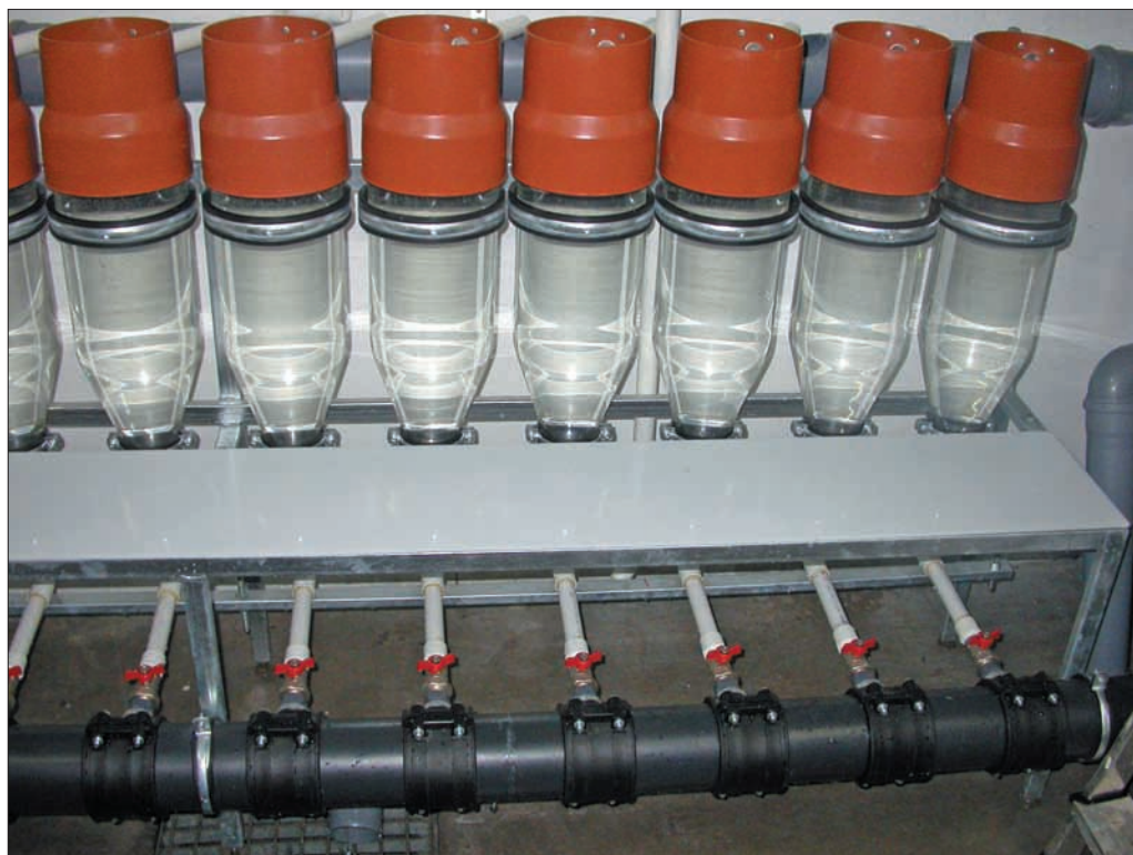
Fot. 3. Rozmieszczenie zaworów wprowadzających wodę do aparatów Weissa.
