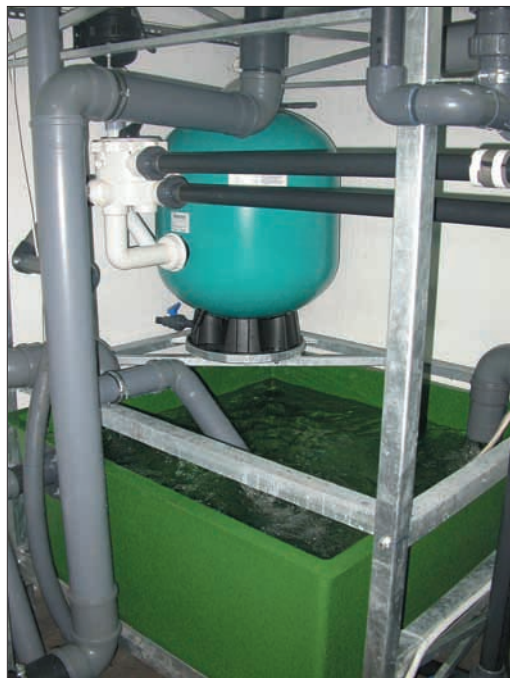
Fot. 6. Filtr mechaniczno-biologiczny w wylęgarni szczupaka.
